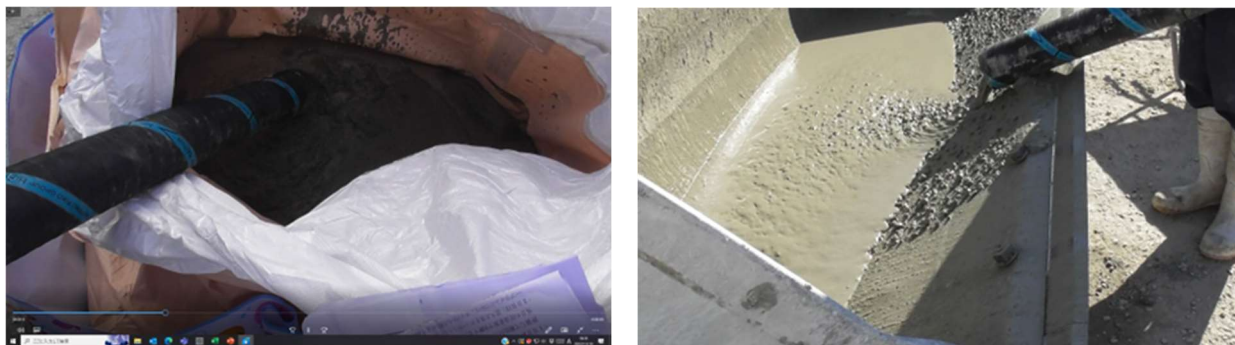
写真 11 筒先の生コンの状態
