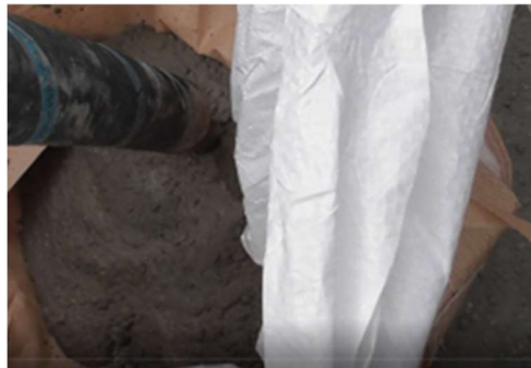
写真 15 筒先の生コンの状態
