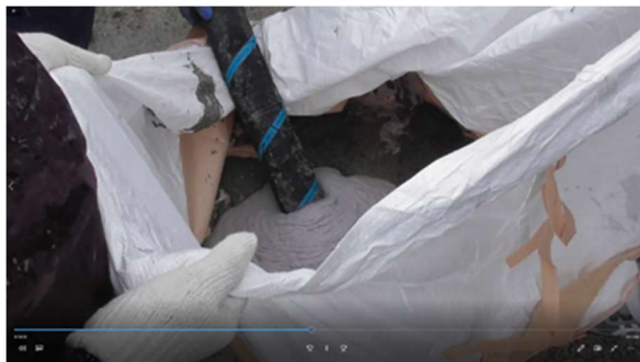
写真 18 筒先の生コンの状態
