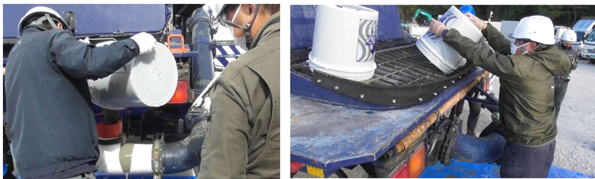
写真 10 ポンプ車への投入方法 左:T 字管からの投入 右:ホッパからの投入
