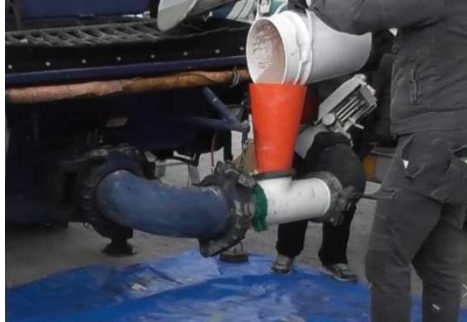
写真 14 ポンプ車への投入方法
