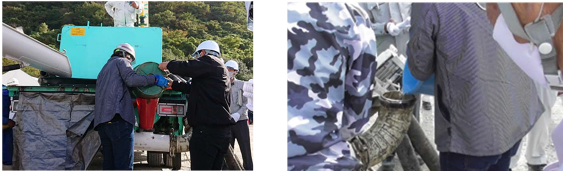
写真 5 ポンプ車への先送り材投入方法 左:T字管からの投入 右:ベント管からの先行水投入
