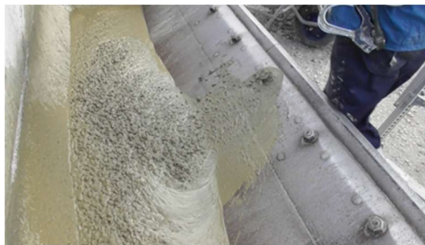
写真 7 筒先の生コンの状態
