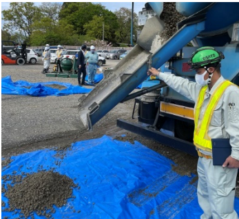
改質後に排出された生コン
